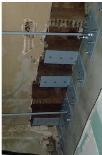
Reforço sísmico com tirantes e ligação paredes/ pavimento
