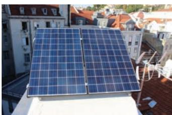
Sistema fotovoltaico, com recurso a painéis solares, para fornecimento de energia ao elevador
